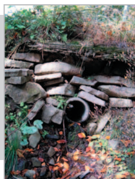
Przepust pod drogą na Klimczok w Szczyrku Jadwiga Wrzesińska – godło KLIMCZOK
