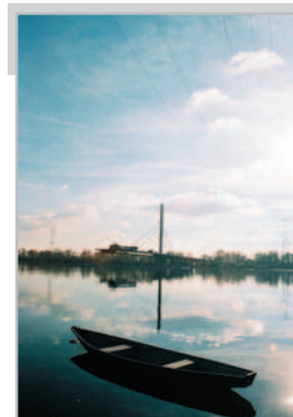
Nowo budowany most podwieszony w Płocku Andrzej Berger – godło ALPINISTA
