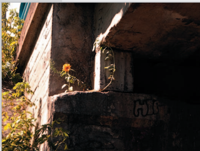
III nagroda – Krzysztof Germaniuk Przyczółek mostu nad Kanalem Królewskim w Nieporęcie
